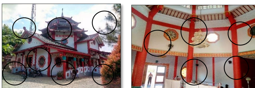
Gambar 29. Tata letak ventilasi segi delapan di luar dan di dalam Masjid Cheng Hoo Purbalingga (Sumber: Dokumentasi Imam Ramadhan, 2017)
